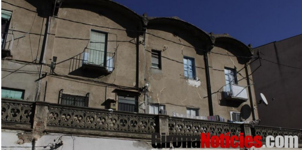
Edificis que s'enderrocaran
