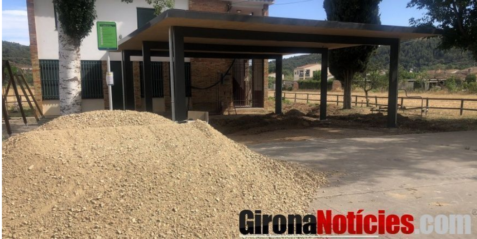
Obres pista Campdorà
