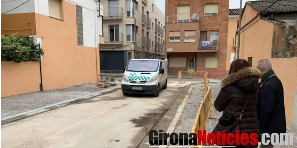
Obres carrer Riu Freser
