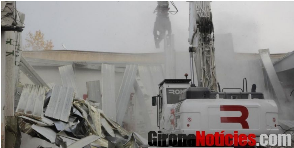
Enderroc interiors de l'antiga fàbrica Simon
