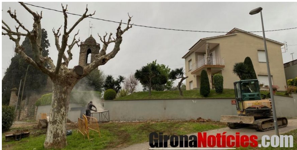
Obres plaça de Guèmol
