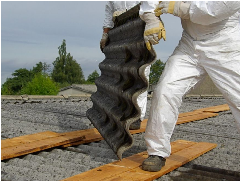
Operari retirant fibrociment d'una coberta / Generalitat de Catalunya
