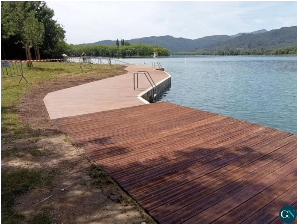
Nova tarima de fusta Caseta de Fusta / Aj.Banyoles
